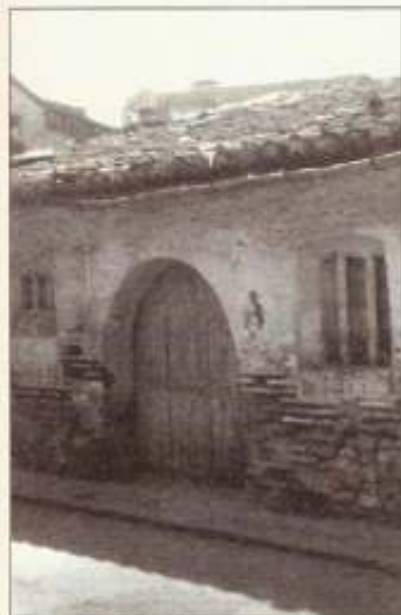
Casa del carrer del Forn, d'arc de ferradura i amb finestres de barrots de fusta.
